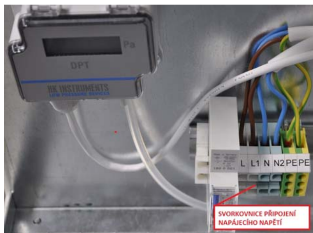
Obr. 1 - Svorkovnice napájecího napětí
