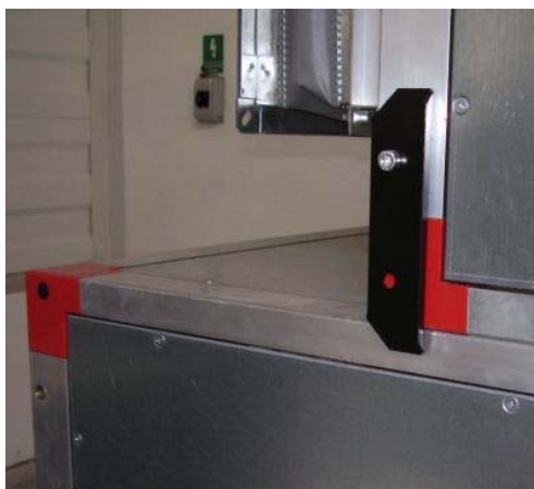
Obr.6 ÚPRAVA PRO VENKOVNÍ PŘEVODNÍ - DODATEČNÉ ZAJIŠTĚNÍ KOMOR
